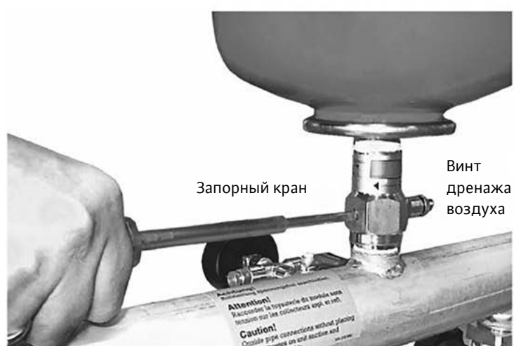
Рис. 2б. Обслуживание мембранного бака и проверка давления воздуха в нем.
